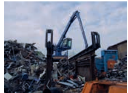
Das bestehende Gleisfundament wurde wieder genutzt – auch eine Platzfrage.
